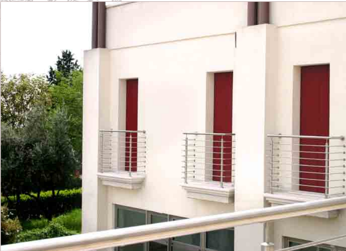
Parapetti per balconcini francesi con tondini orizzontali A frontal view of the french balconies Balconadas para terrazas francesas con varillas horizontales. Garde-corps pour balcons français avec ronds horizontaux
