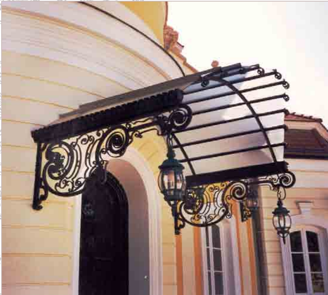
Tettuccio di protezione dell'ingresso alla torre Protection roof at the tower entrance Techado de protección de la entrada a la torre Petit toit de protection d'entrée à la tour
