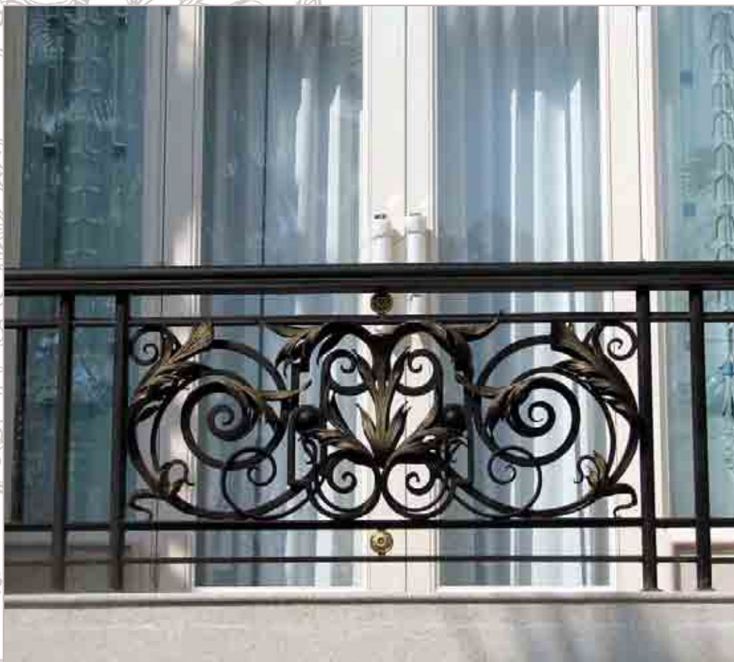
Parapetto stile Impero di terrazzino in Ferro Battuto patinato con polvere d'oro Empire style balcony in the terrace of Wrought Iron patinated with golden powder Barandilla en pequeña terraza, de estilo Imperio en Hierro Forjado patinado con polvo de oro Garde-corps style Empire de terrasse en Fer Forgé, patiné avec poudre or
