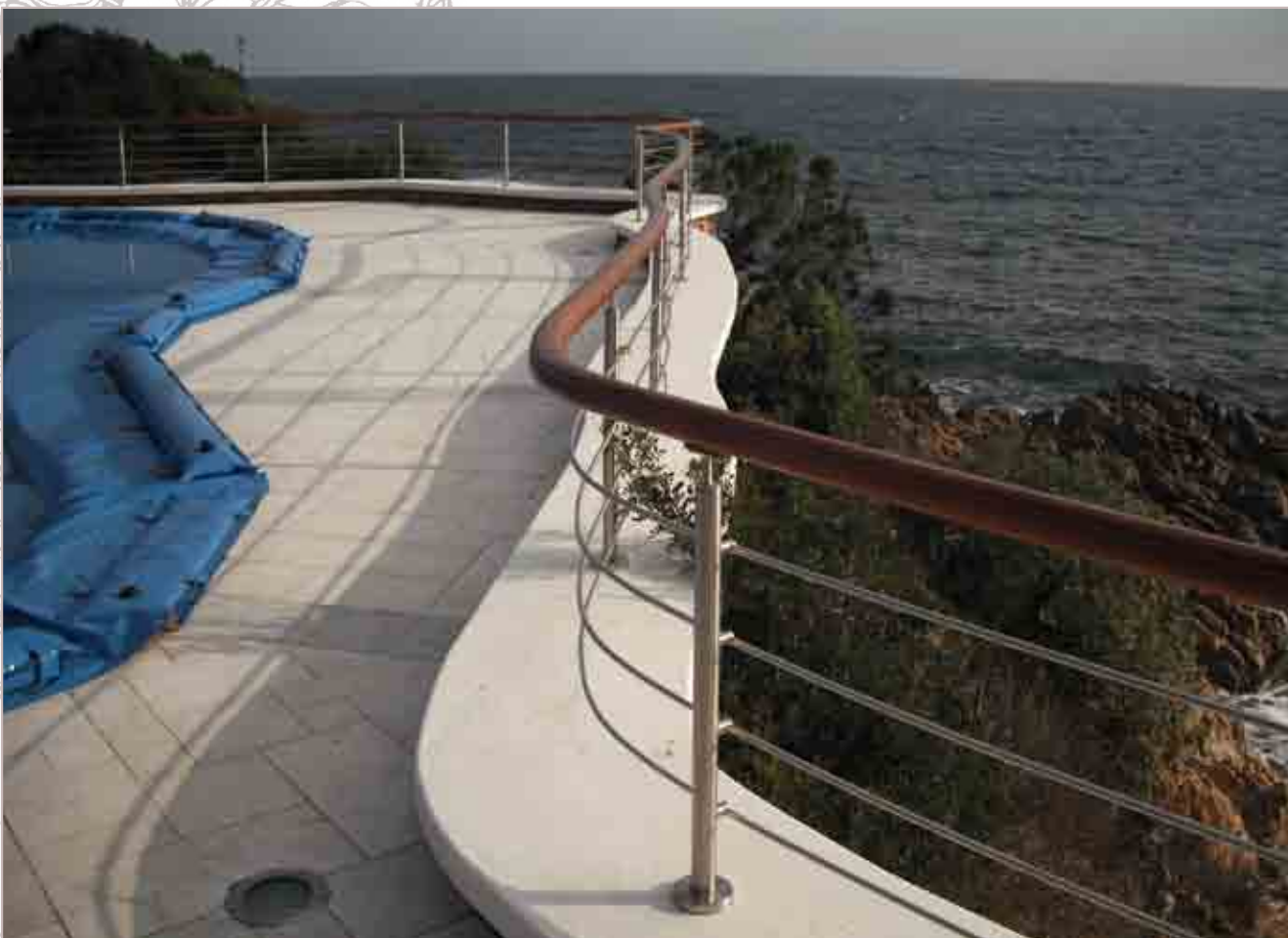
Parapetto delimitativo tra piscina e mare a seguire la morfologia del terreno in Acciaio Inox e corrimano in legno trattato sagomato Separating parapets between swimming pool and sea following the morphology of the ground in stainless steel and handrail in shaped treated wood. Barandilla separadora entre piscina y mar siguiendo la morfología del terreno en Inox y pasamano en madera perfilada tratada Garde-corps délimitatif entre piscine et mer suivant la morphologie du sol avec acier inox et main-courante en bois traité façonné
