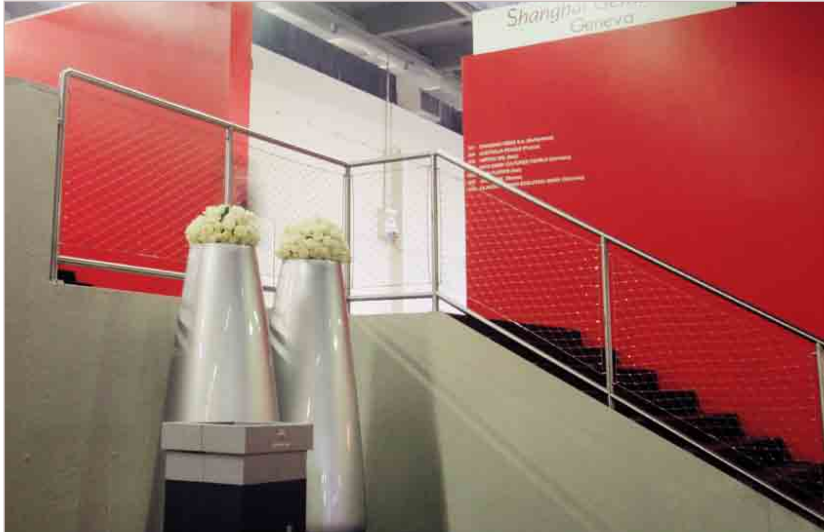
Parapetti e rampe scale Balconies and staircase Barandillas y rampas escaleras Garde-corps et volées d'escalier
