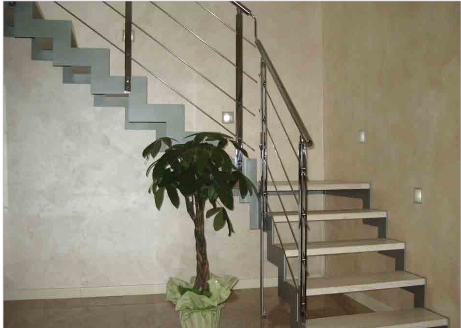
Rampa scala interna con cosciali di sostegno gradini. Tutto Inox AISI 304 Rampa de escalera interior con sujeciones laterales de las gradas. Todo en Inox AISI 304
